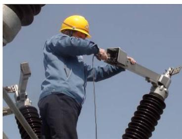
第三步 测量触指压力
