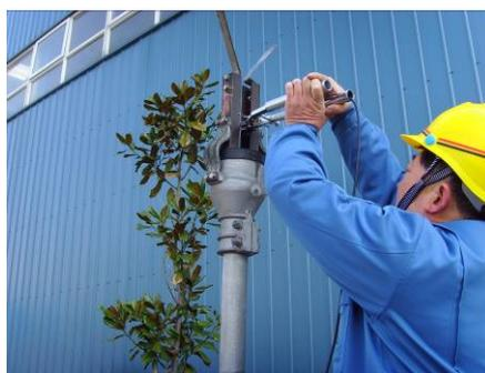
第三步 测量触指压力(未挂静触头)
