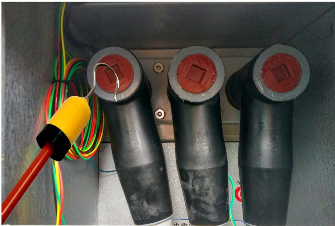
接线 T 头核相操作示意图（图 4）
