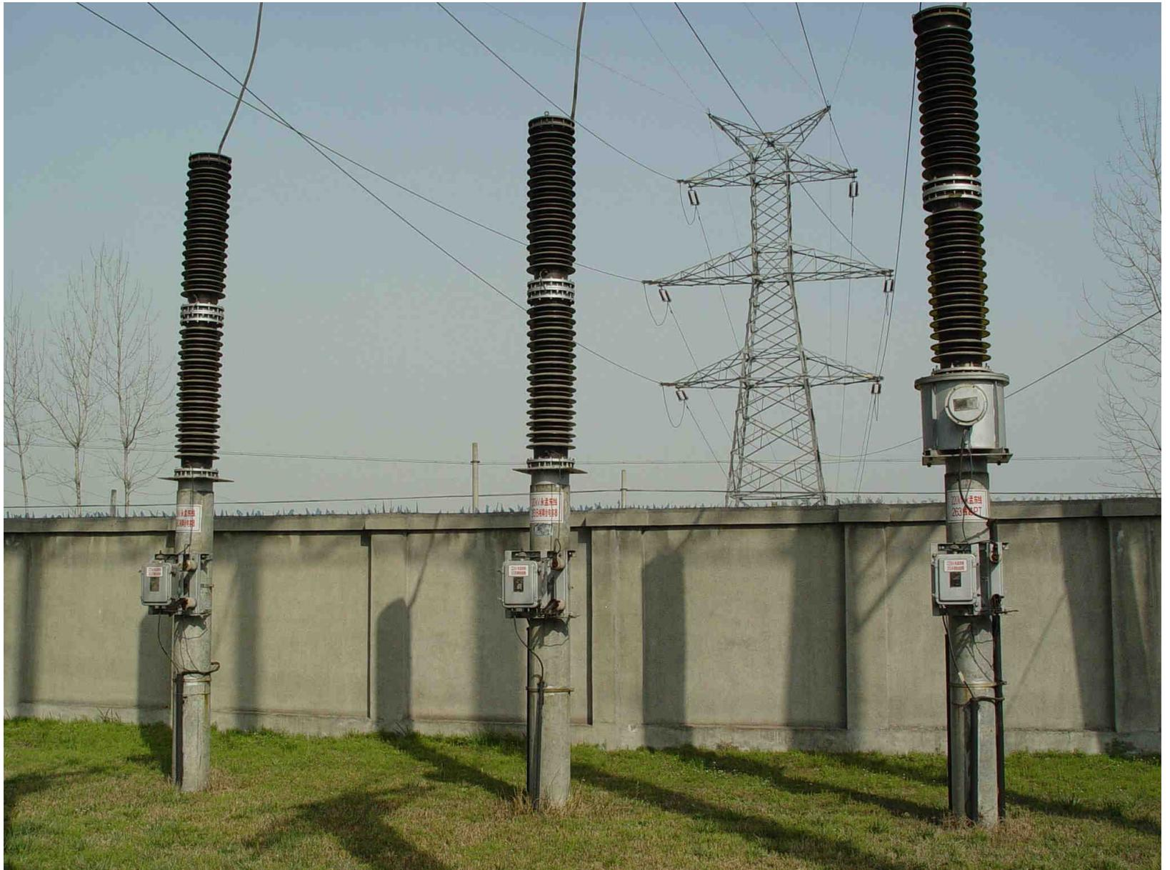
220kV 耦合电容器、电容式电压互感器
